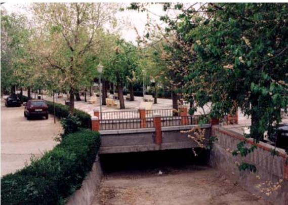
Tramo medio y cubierto del Arroyo.
