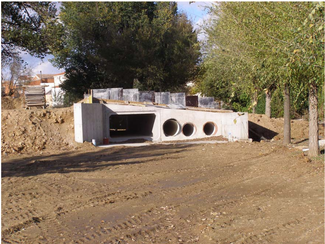
Fig.30. Imagen tomada en 2006 de la construcción de los nuevos puentes en la calle Prado.
