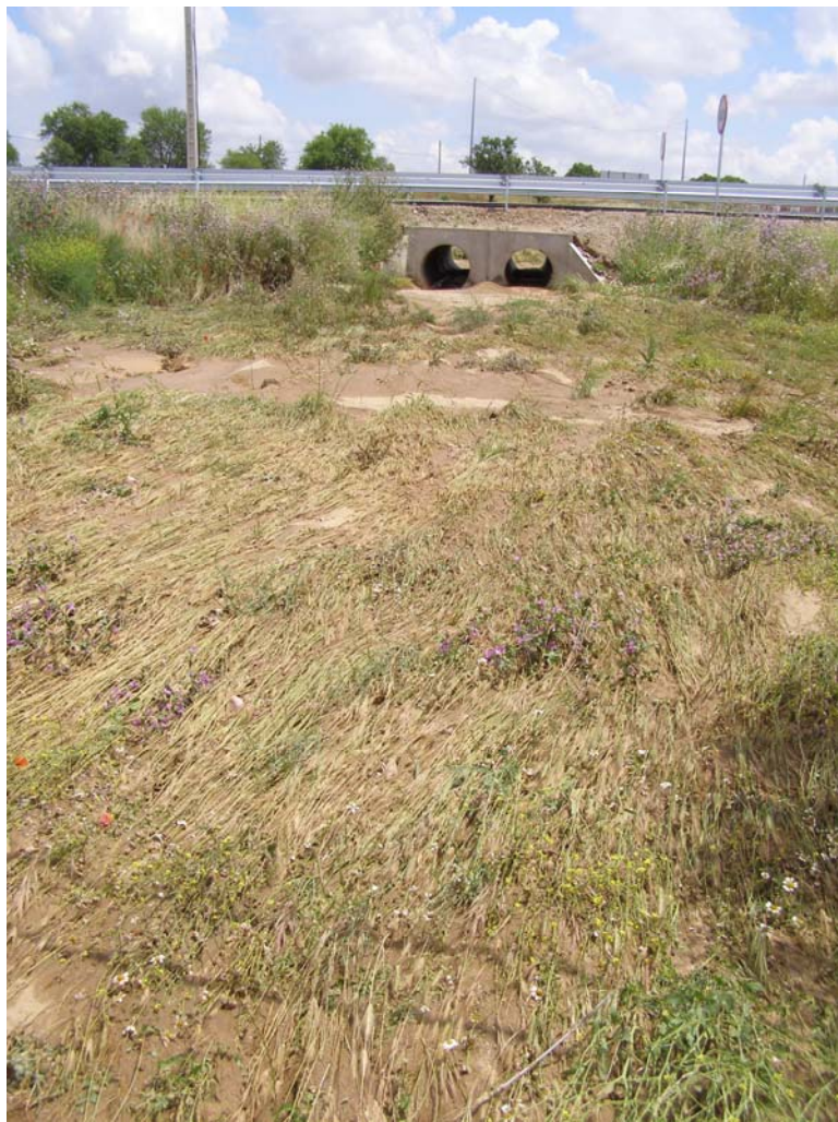
Fig. 28. Tubos de desagüe en la carretera Polán-Casasbuenas.
