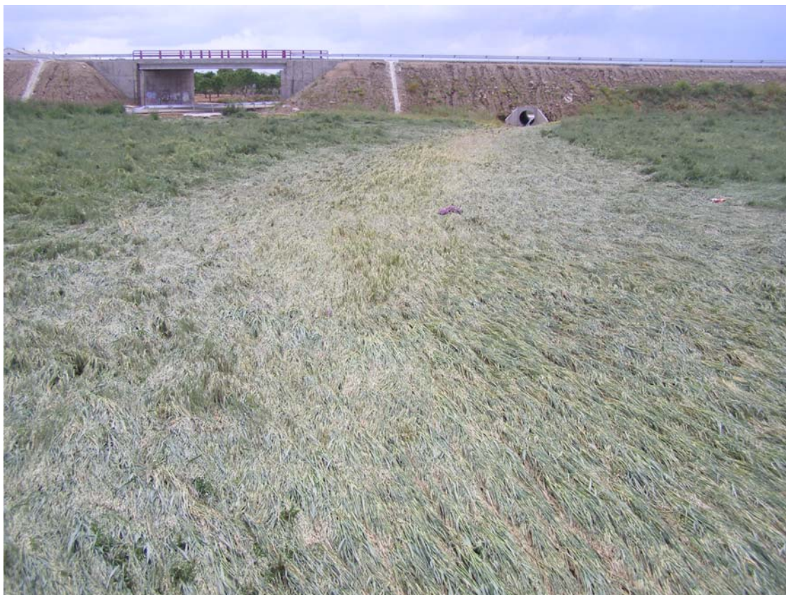
Fig. 29. Desvío de la carretera CM401, "aguas arriba" de Polán. Se comprueba, claramente, que "el agua busca su camino de siempre". Imagen tomada en mayo de 2007.
