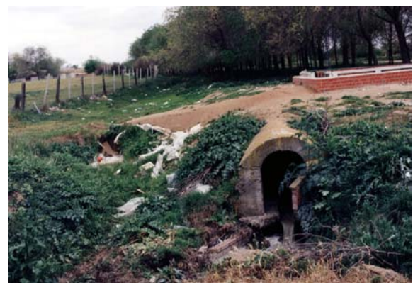
Final de la canalización del Arroyo.
