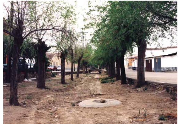
Inicio de la canalización del Arroyo.
