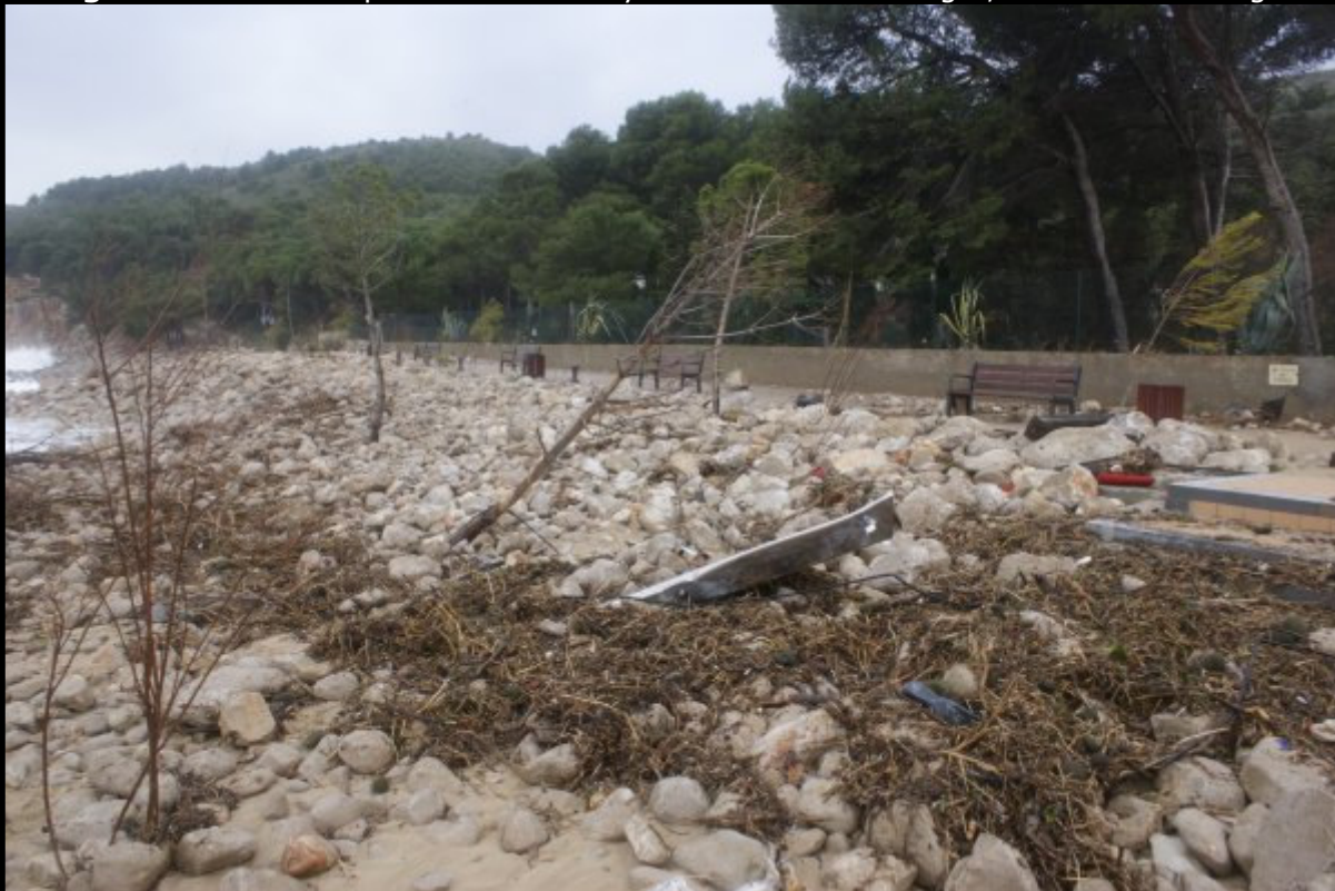
Figura 29: Paseo sepultado de rocas y arena en Cala Montgó , autor: David Falgàs.
