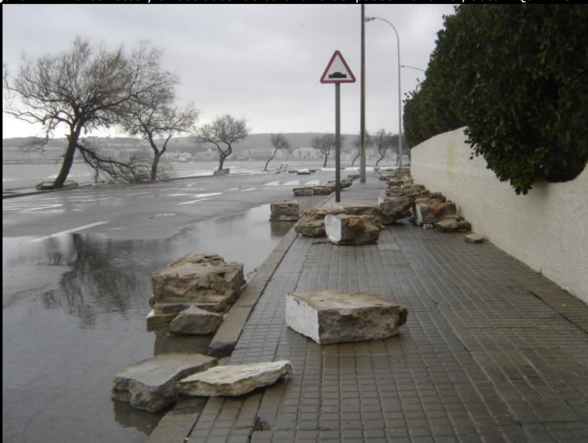
Figura 27: Trozos rotos y arrastrados de barandilla del paseo marítimo , autor: Quim Teixidor.
