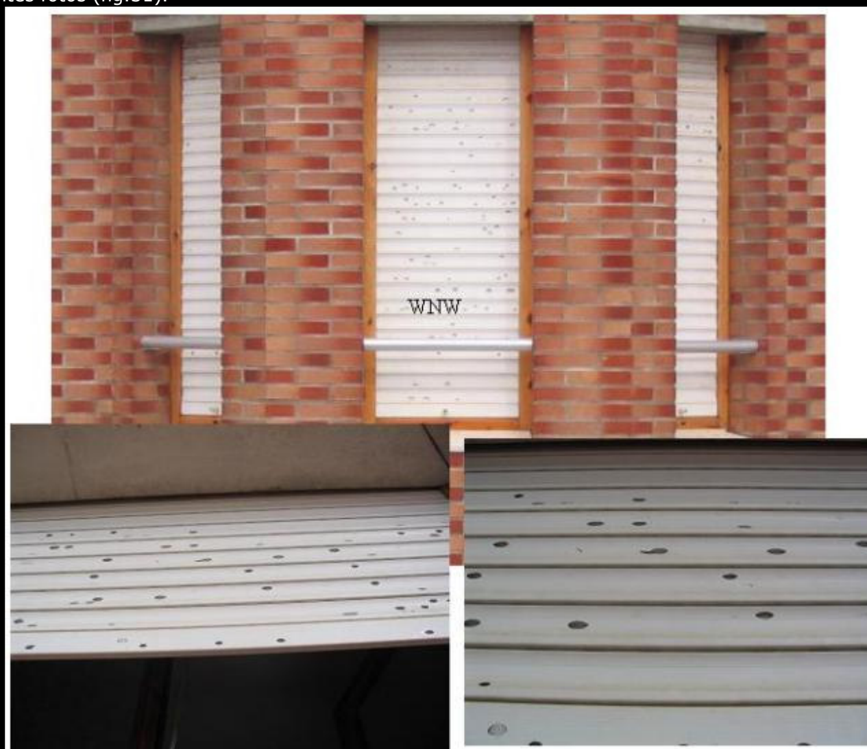
Figura 31. Imagen del efecto del granizo sobre las persianas de las viviendas
