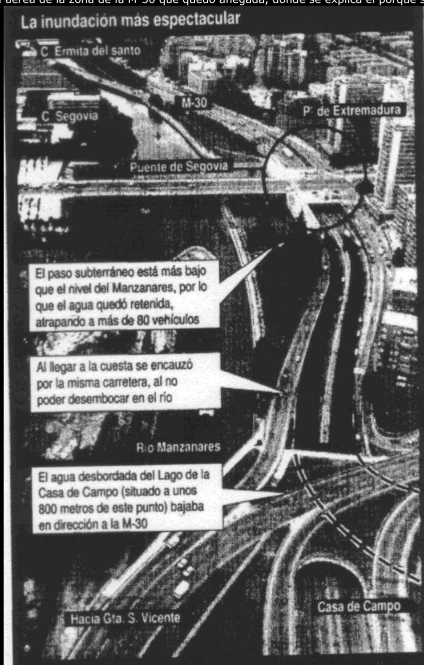
Figura 41: Imagen aérea de la zona de la M-30 que quedó anegada, donde se explica el porqué se dio dicha situación.
