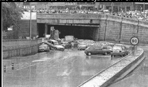
Figura 0. Aspecto de la M-30 tras el diluvio que dejó decenas de coches atrapados y cubiertos de barro. Se puede observar la altura que alcanzó el agua en las marcas dejadas en el muro de la izquierda.
