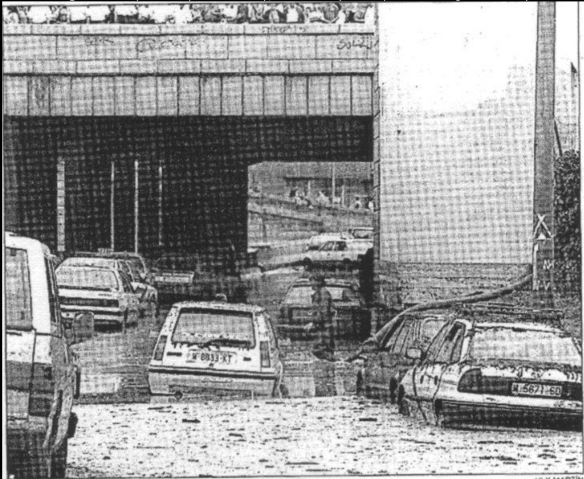
Figura 29: Aspecto del puente del Rey, en la M-30 (foto ampliada de la figura anterior)
