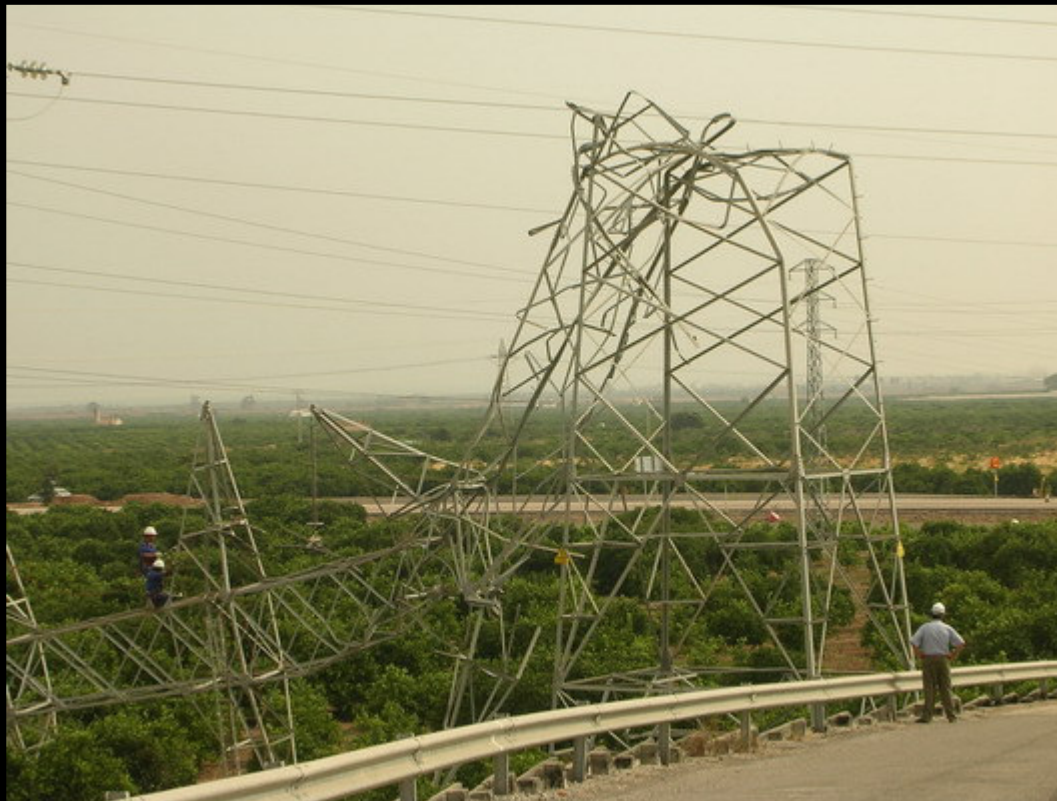
Foto 33 – Una de las 3 torres de 220.000 Kilovoltios. Resiste ni más ni menos que 36.000 kilos de peso.
