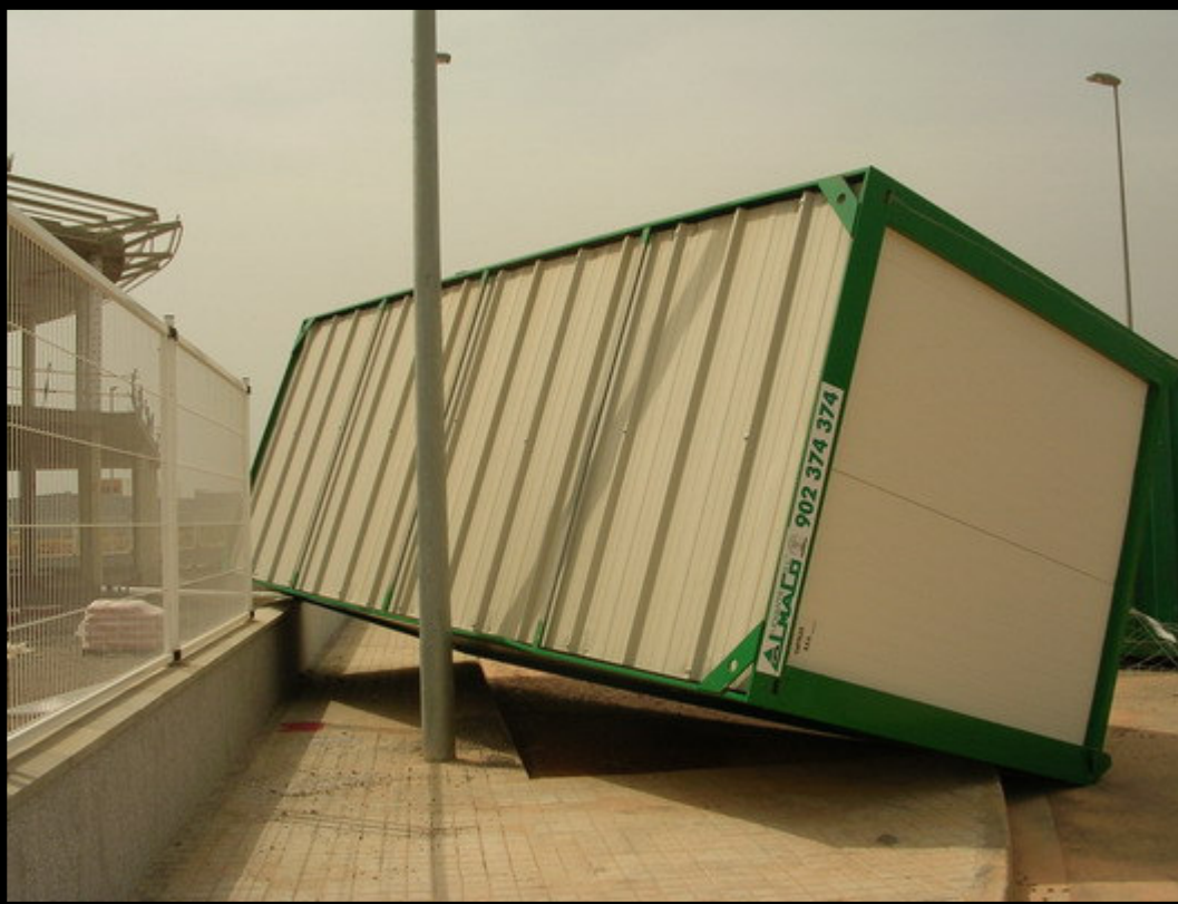
Foto 24 – La misma caseta desde el otro lado, a punto de derribar una farola.
