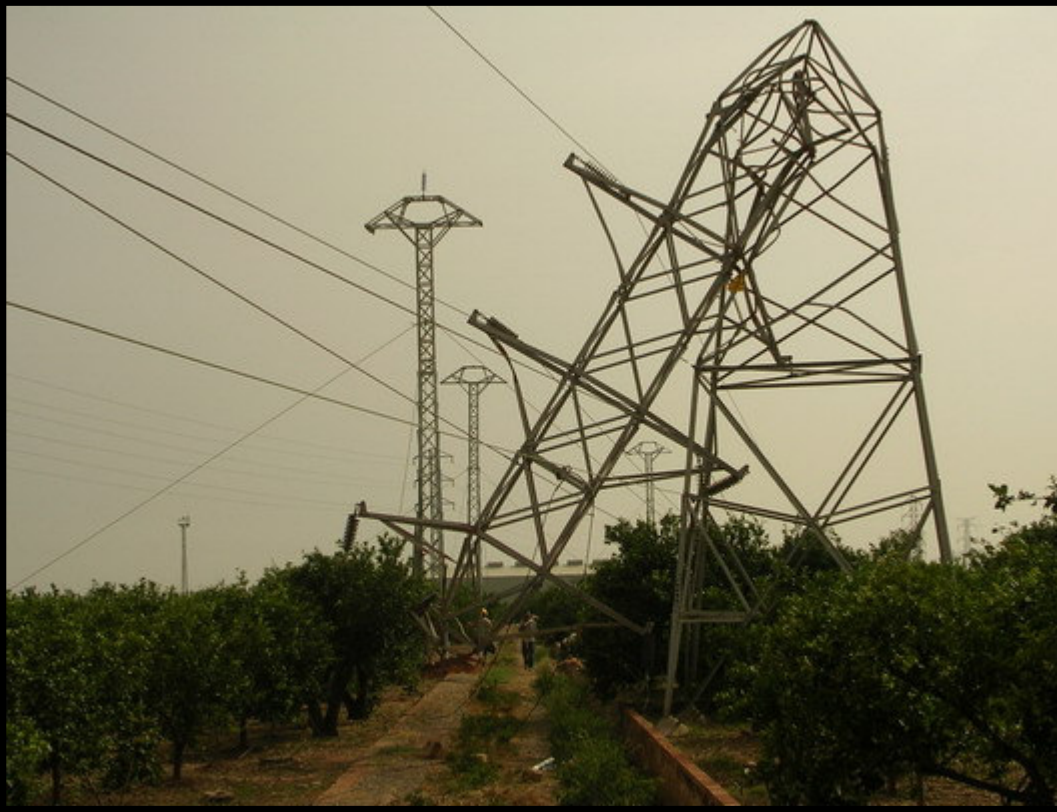
Foto 32 – Otro ángulo de la misma torre. Gran trabajo de los operarios de Iberdrola.
