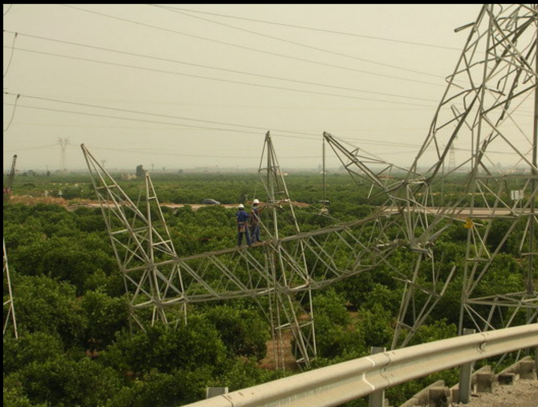
Foto 34 – Detalle de la misma torre en Gausa, mientras los operarios trabajaban para cortarla.
