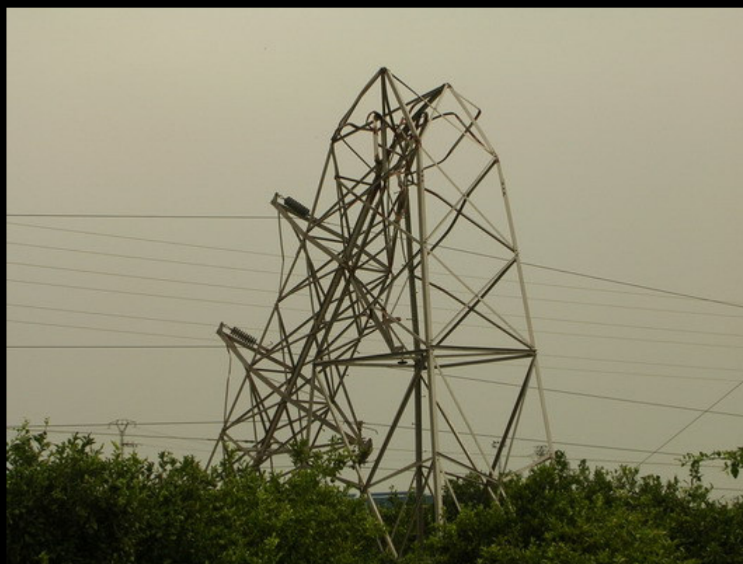
Foto 31 – Una de las 3 torres de 66.000 Kilovoltios doblada como papel de fumar en Gausa.
