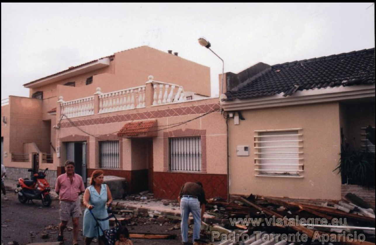
Figura 27. Más daños en diferentes casas de la zona
