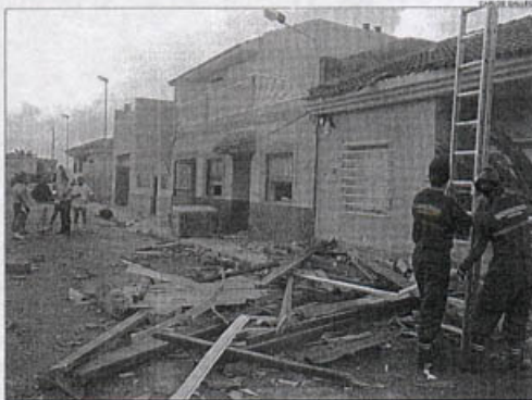
Los daños que causó el tornado fueron importantes, como se aprecia en la imagen
