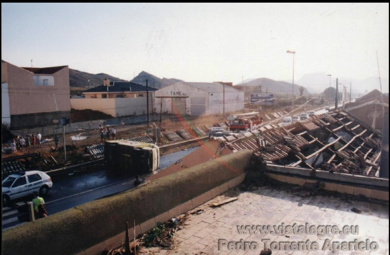
Figura 21. Perspectiva general de los destrozos
