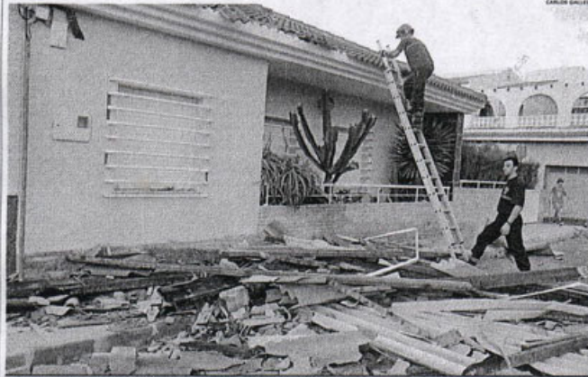
Los bomberos mientras revisan uno de los tejados afectados por el tornado
