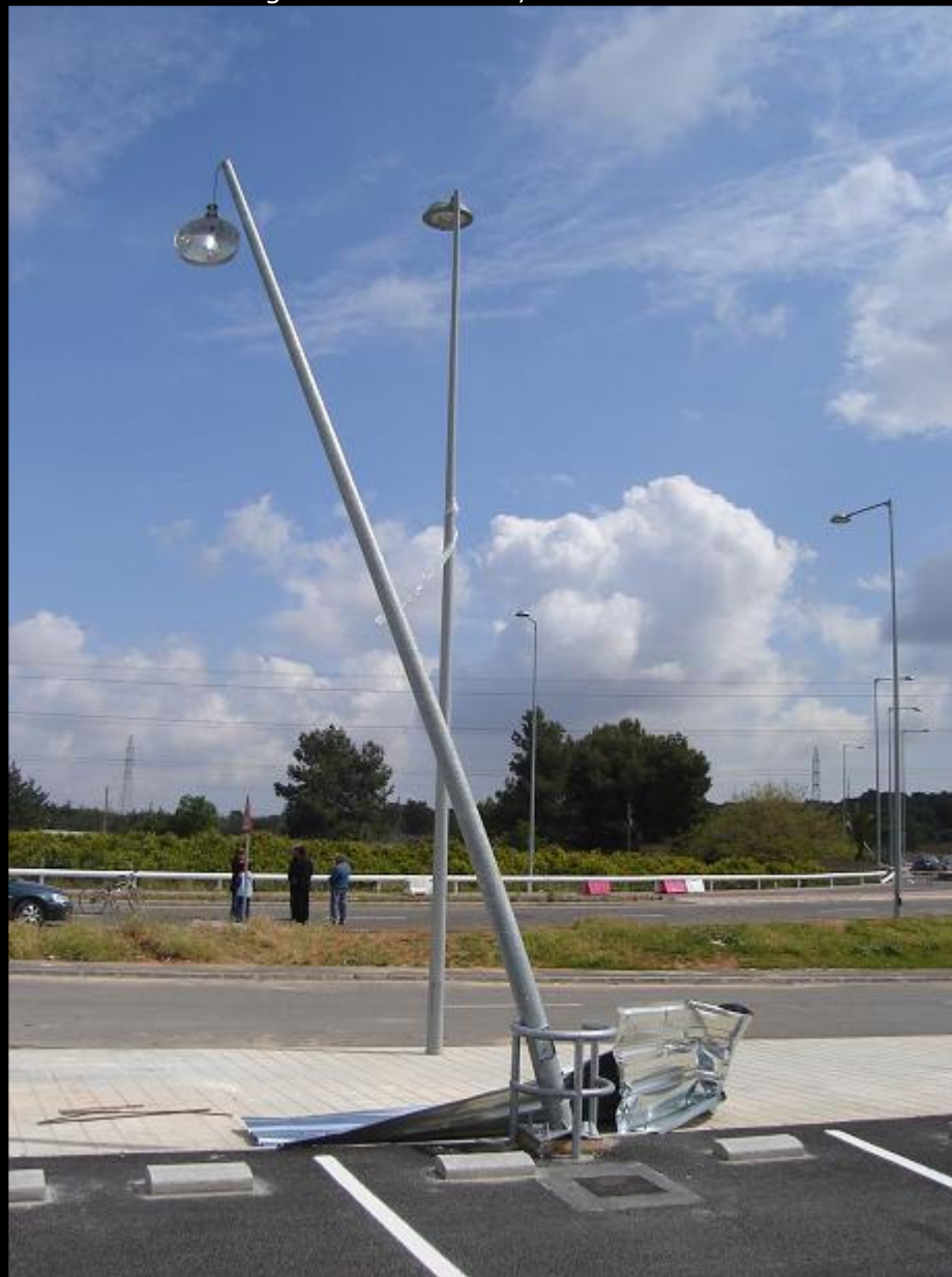
Imagen 35. Farola dañada pero no partida. En este caso vemos que no hay papelera, por lo que la farola no se parte, sino que toda la fuerza la sufren los enganches inferiores, sobre la obra de la calzada.
