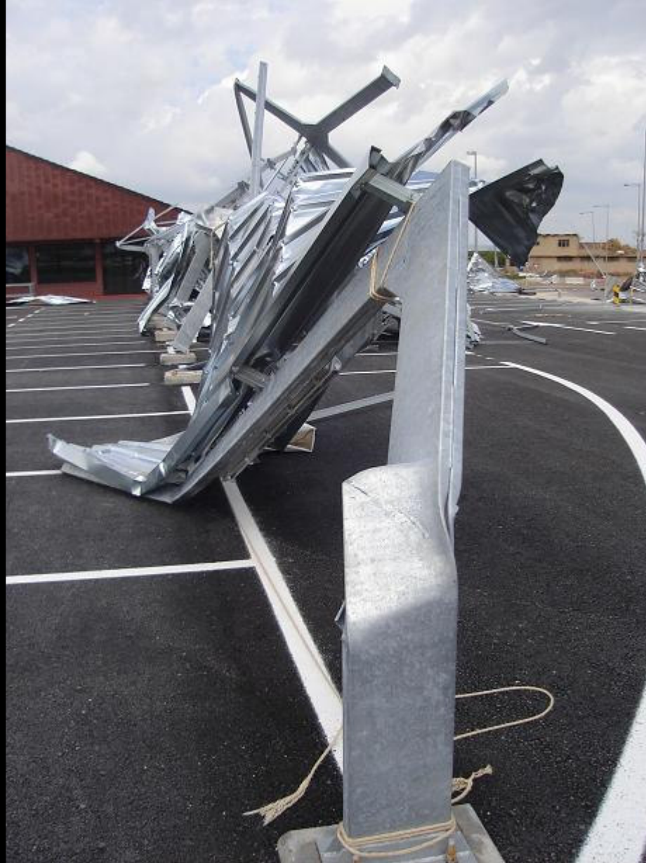
Imagen 25 . Hierros levantados y estampados entre sí.
