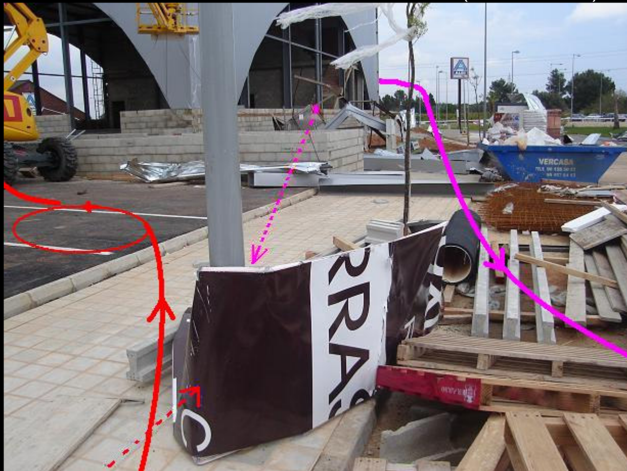
Imagen 21: Mirando hacia el norte, desde un punto algo alejado del edificio-obstáculo. El cartel "CHURRASCO" fue arrancado y destrozado como si fuese papel, desplazándose muy al sur en el recorrido inicial, para posteriormente ser devuelto casi al mismo lugar, doblándose según la orientación y trayectoria final sur-norte, sobre una farola. Fíjense que el cartel está más doblado que la placa gris que está en el fondo, sobre los hierros. La flecha fucsia discontinua indica el recorrido efectiva (final menos inicial) del cartel..
