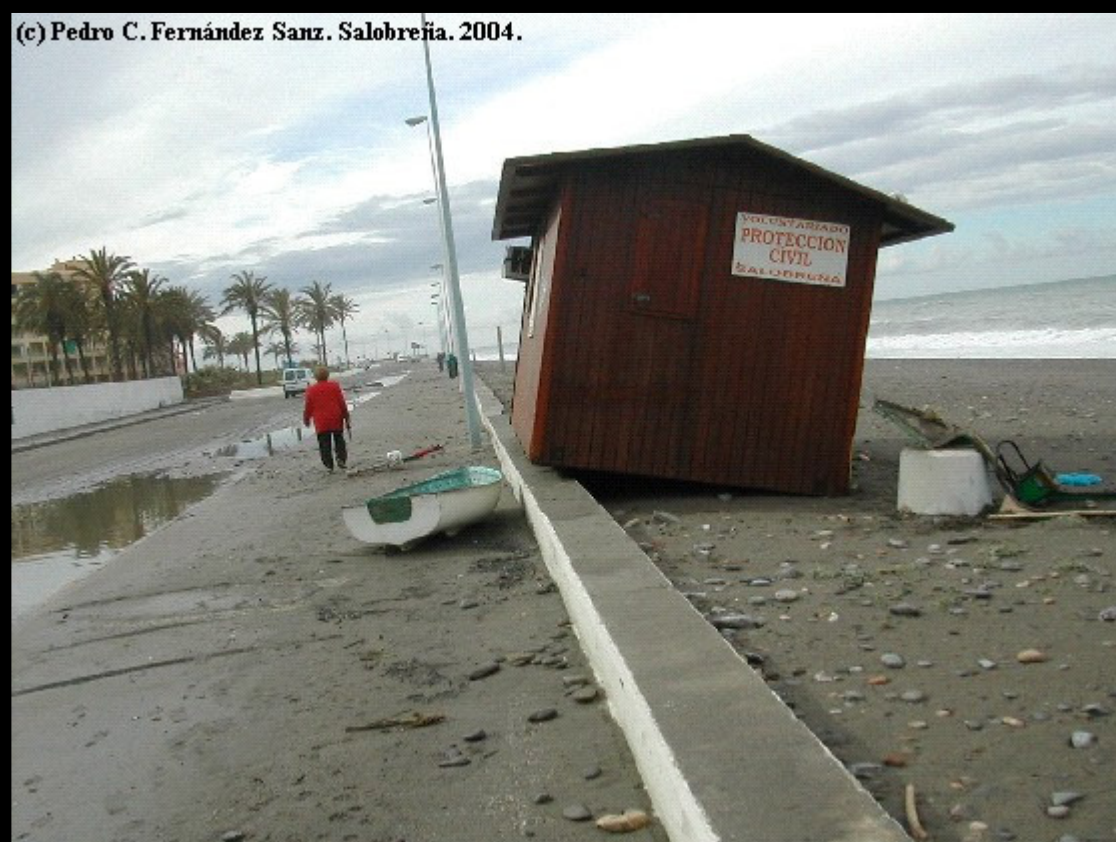
Fig. 3. Ejemplo de los daños (I). Fuente: material fotográfico propio.
