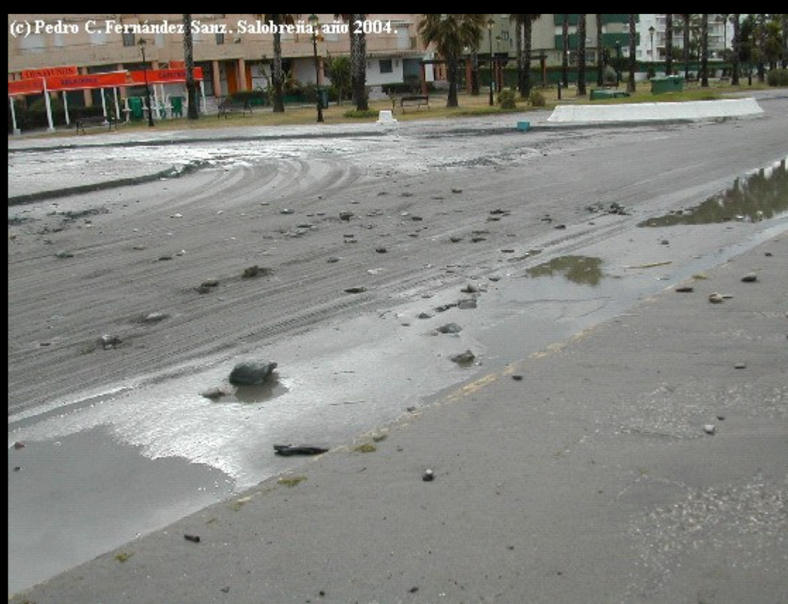
Fig. 13. Paseo marítimo de Salobreña. Nuevo detalle de los restos dejados por el mar.
