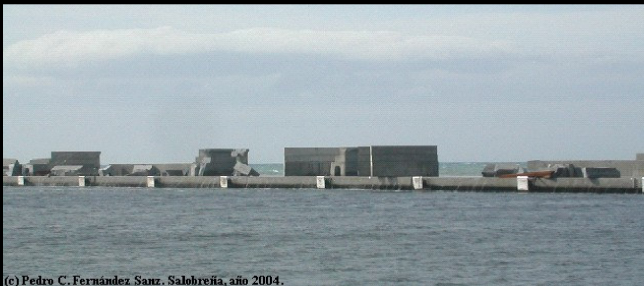
Fig. 18. Estado en el que quedó el nuevo espigón del Puerto de Motril, completamente destrozado, siendo estos elementos visibles de hormigón y de cientos de toneladas de peso. Las olas saltaron por encima de ellos sin romper.
