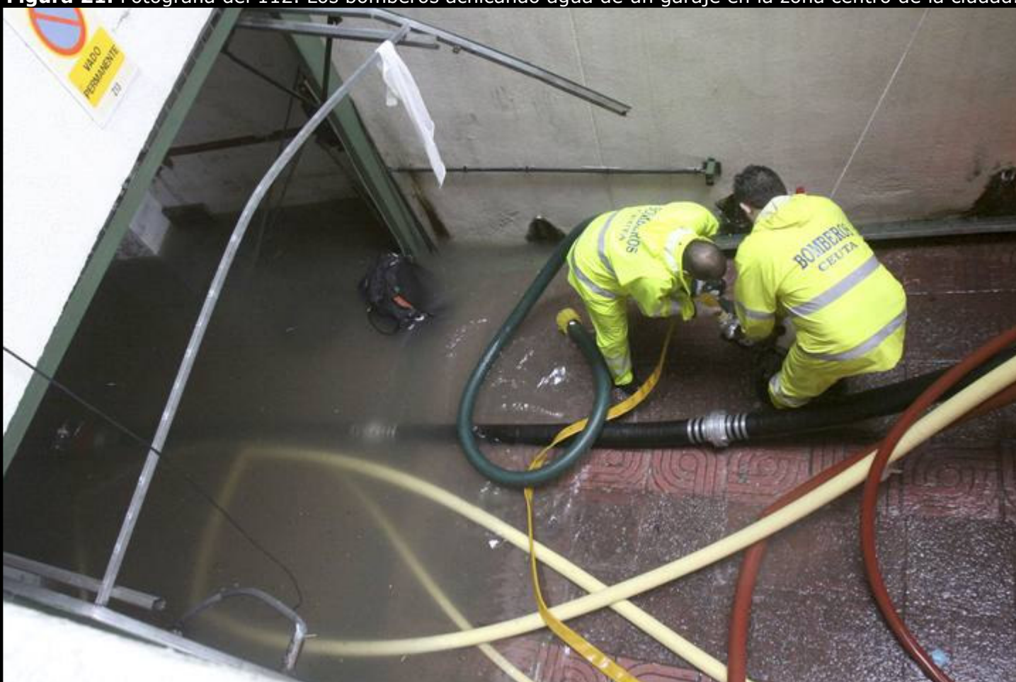
Figura 21. Fotografía del 112. Los bomberos achicando agua de un garaje en la zona centro de la ciudad.
