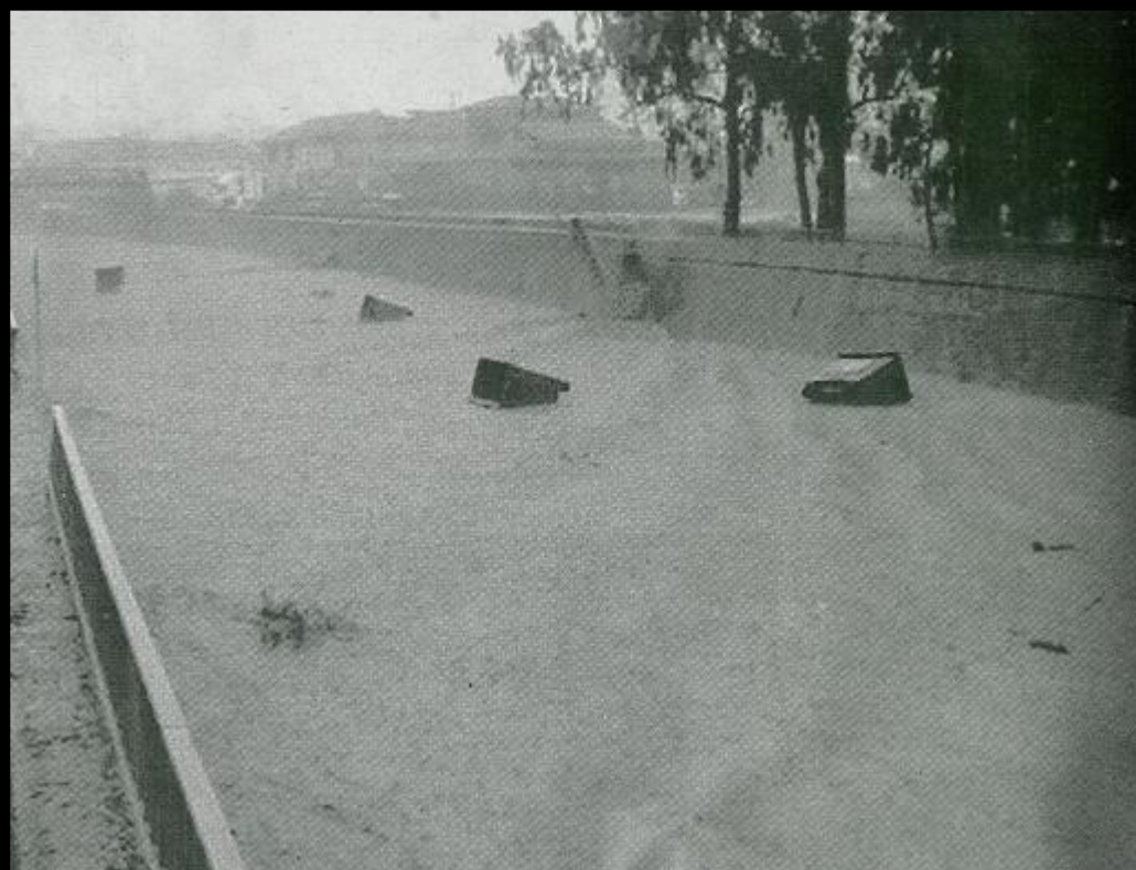
Figura 37.- Y una tercera imagen de la misma rambla, y que también apareció en las páginas interiores... numerosos objetos, como contenedores de basura, eran arrastrados por las aguas...
