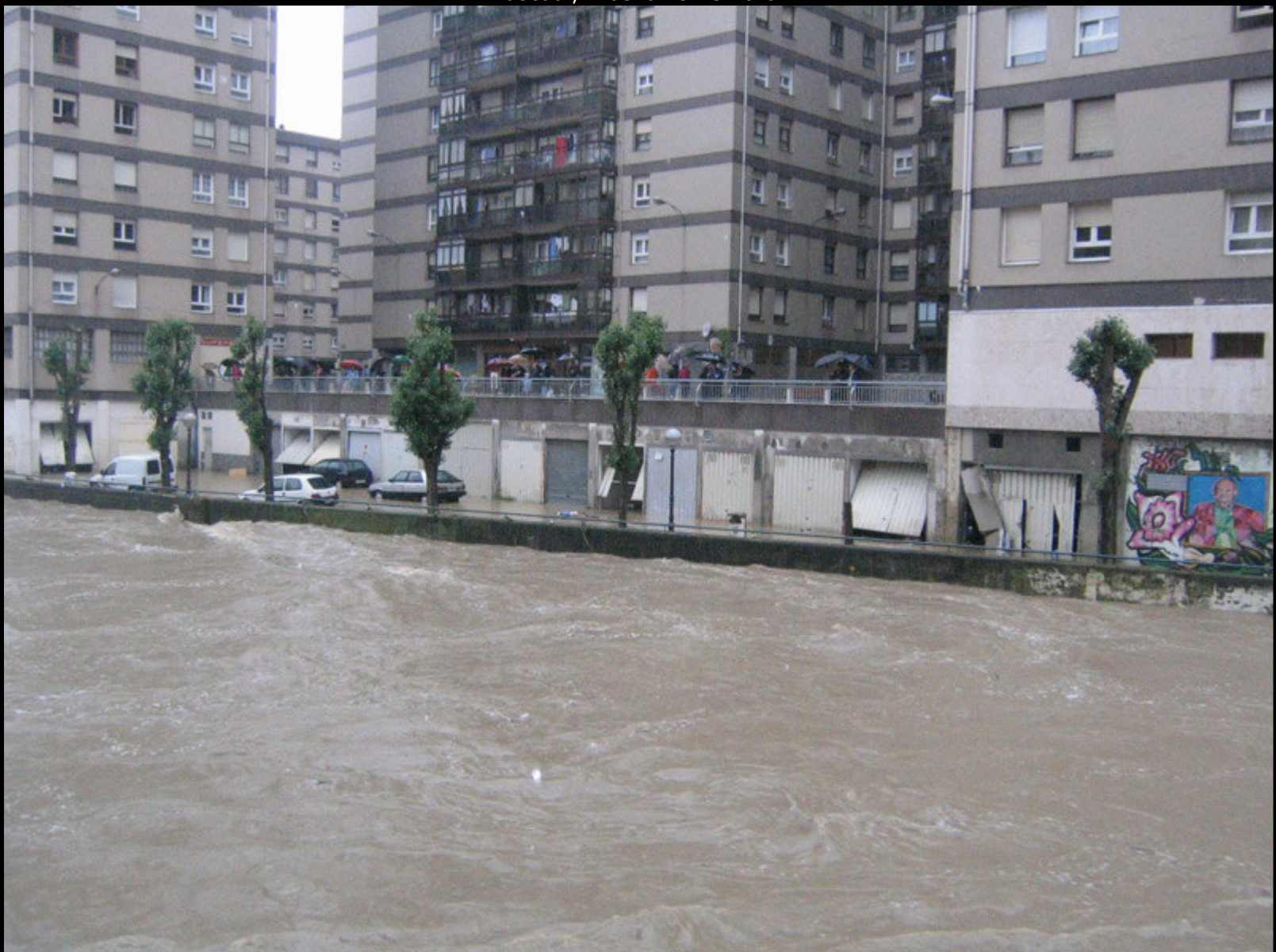
Figura 24: De nuevo el Nervión en Basauri, se aprecian coches a los que el agua cubrió completamente y los garajes y lonjas dañados. Fuente: David Pascual, "Pasku" en el foro.
