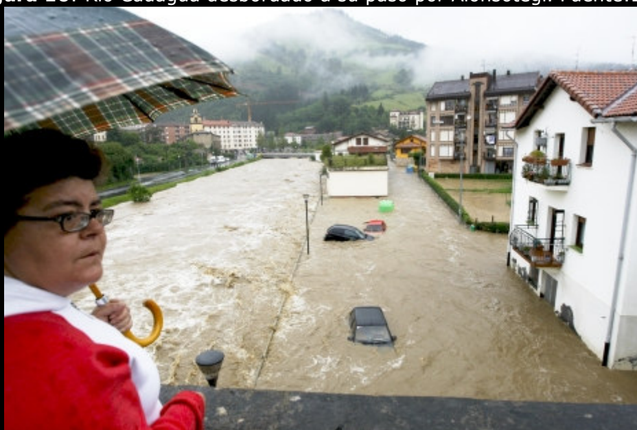
Figura 16: Río Cadagua desbordado a su paso por Alonsótegi. Fuente:Deia.
