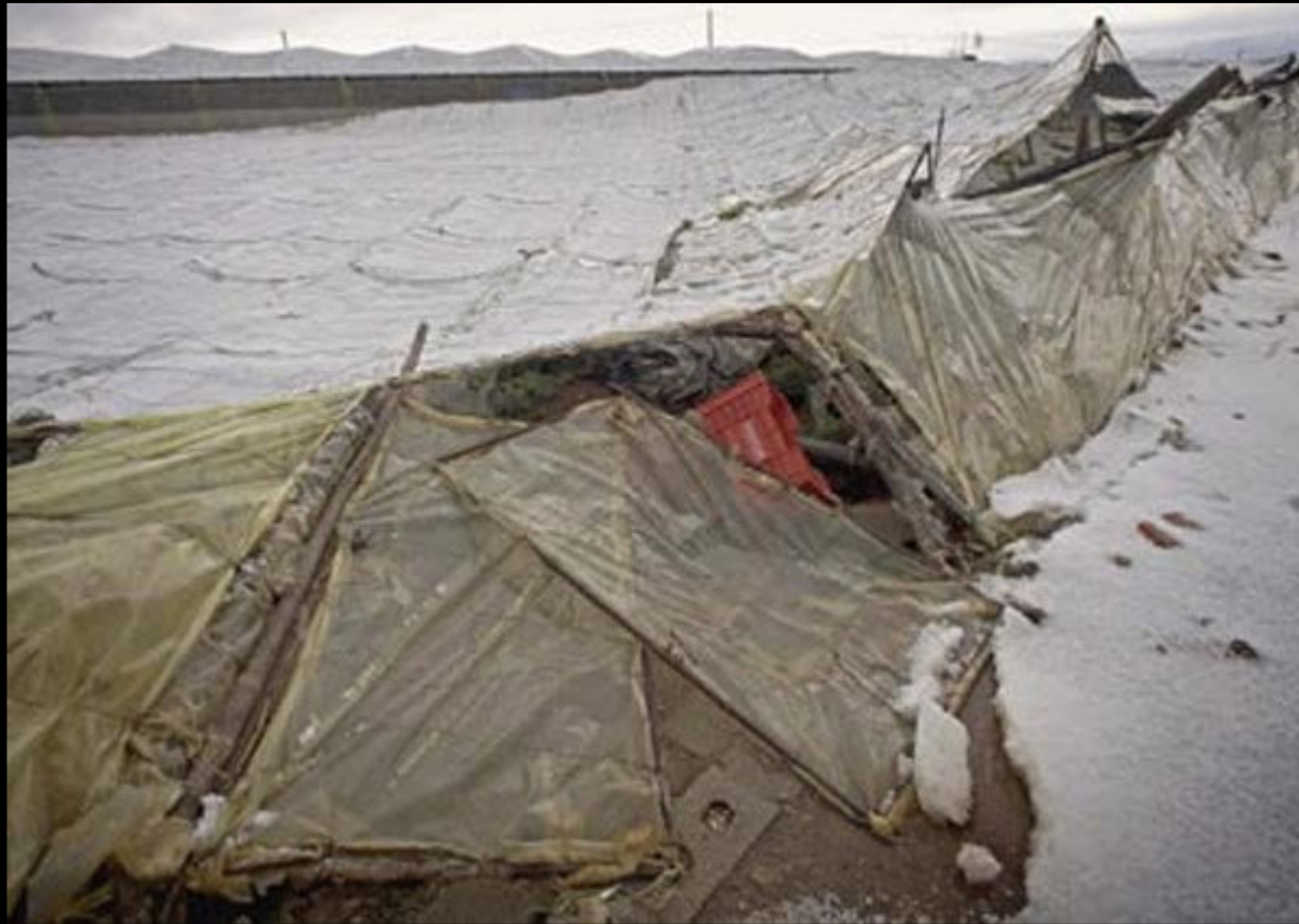
Fig. 40: Muchos invernaderos como este se vinieron materialmente abajo debido a la acumulación de tanta piedra... Las pérdidas en la agricultura fueron desastrosas...
